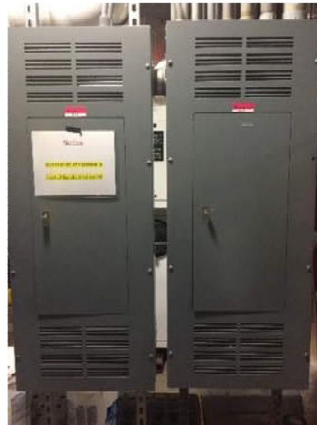
Fig. 37 - Existing panel A1
